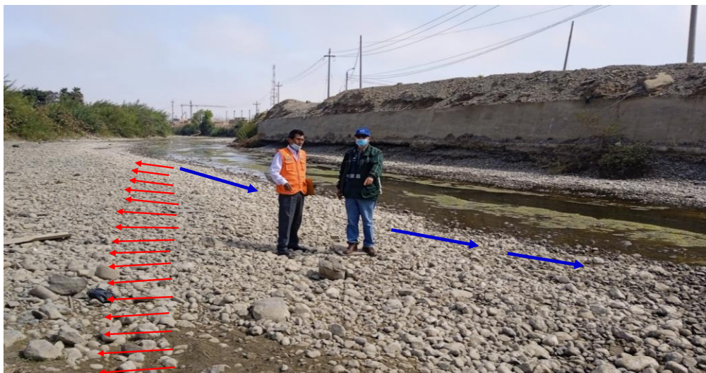
FIGURA N°03: EN LA TEMPORADA DE MAXIMAS AVENIDAS EL RÍO HUARMEY, SE DESBORDA, POR LA MARGEN DERECHA E IZQUIERDA, EN EL SECTOR PUENTE LOS ARABES, DISTRITO DE HUARMEY- HUARMEY, CUYO TRAMO SE ENCUENTRA COLMATADO Y DESPROTEGIDO, VULNERABLE A LAS VELOCIDADES EROSIVAS DEL RÍO.
