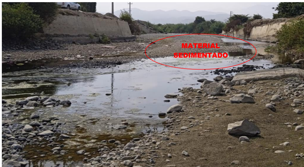
FIGURA N°02: MATERIAL COLMATADO EN EL CAUCE DEL RÍO HUARMEY, CON UNA PROFUNDIDAD PROMEDIO DE 1.0 M. ESTO PROVOCA QUE DESBORDAMIENTO DEL RÍO SEA MAS INMINENTE.
